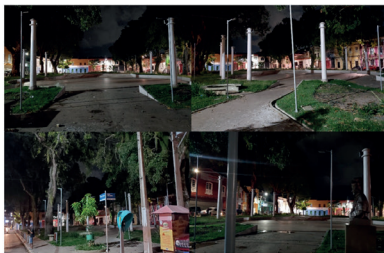
Figura 3 (acima) - A praça sem iluminação após a requalificação. Fonte: Cibelly Figueiredo, 2021. Figura 3 (abaixo) - The square without lighting after the requalification. Source: Cibelly Figueiredo, 2021.
