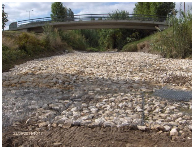
Figura 2 - Execução do colchão Reno no leito do Rio da Costa (Autor, 2011).
