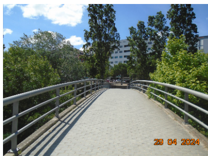
Figura 18 - Ponte com Revestimento em Pavê. (Autor, 2024).
