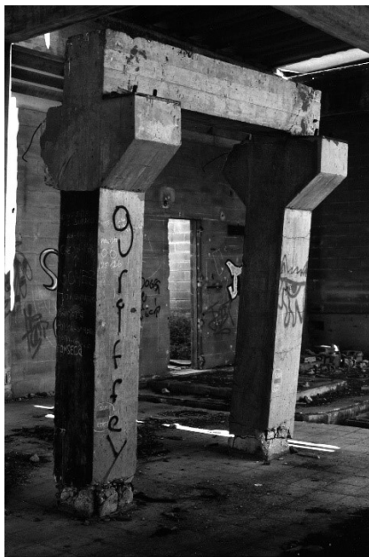
Figura 4. Detalhe do espaço pós-industrial onde se situava a Companhia União Fabril, no Barreiro (captação própria).
