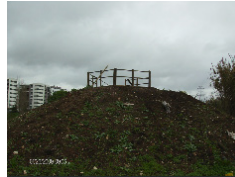
Figura 12 - Aterro e Miradouro. (Autor, 2024).
